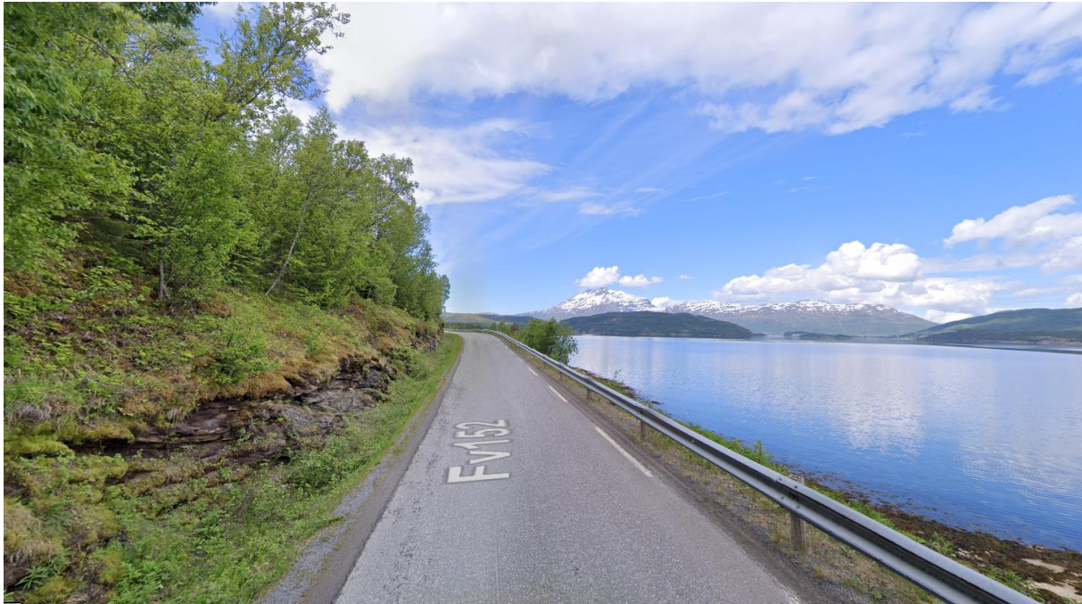
Figur 3 Deler av planområdet sett fra FV 7810 mot vest. Bilde: Google street view
