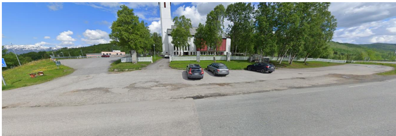
Figur 11 Dagens avkjørsel til kirken.. Google maps.
